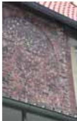
Bei der Abtei handelt es sich um einen Massivbau aus Backstein mit zwei Geschossen, Keller und einem Dachboden, der über eine Dachgaube mittels einer Seilwinde beschickt werden kann. Ein über beide Stockwerke verlaufender Anbau an der Ostseite ist entfernt worden. Der Zeitpunkt des Abbruchs ist nicht bekannt. Auch seine Funktion ist bisher nicht bestimmt werden. Um eine über beide Stockwerke verlaufende Toilettenanlage kann es sich nicht gehandelt haben (Zur
